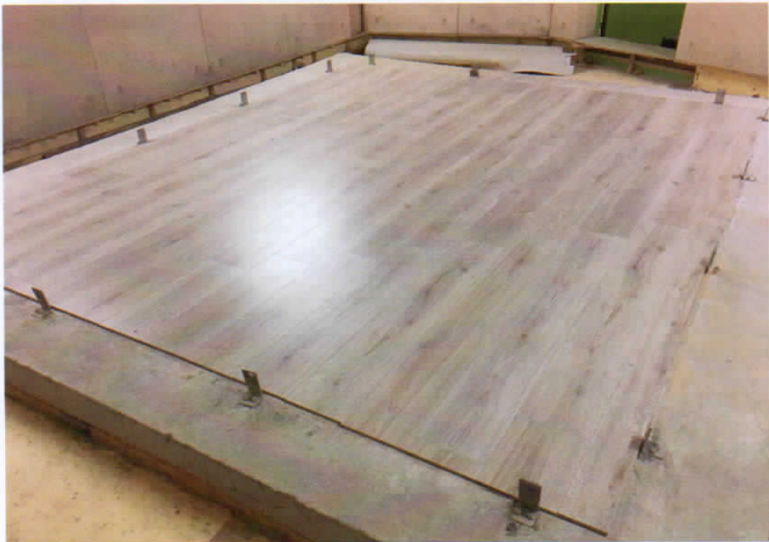
圖6.4 試件施工完成
