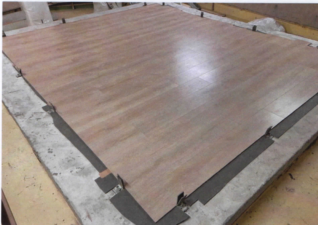
圖6.4 試件施工完成
